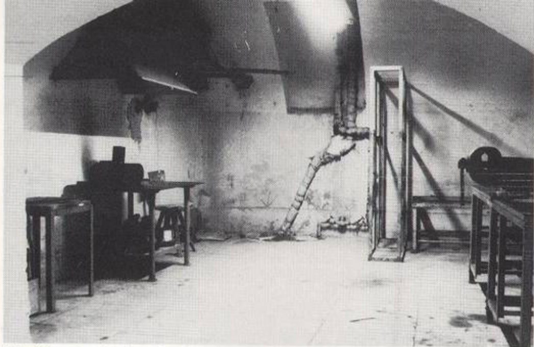
Arbeitsraum in der alten Unterkunft. Links im Bild eine umgebaute Feldschmiede
