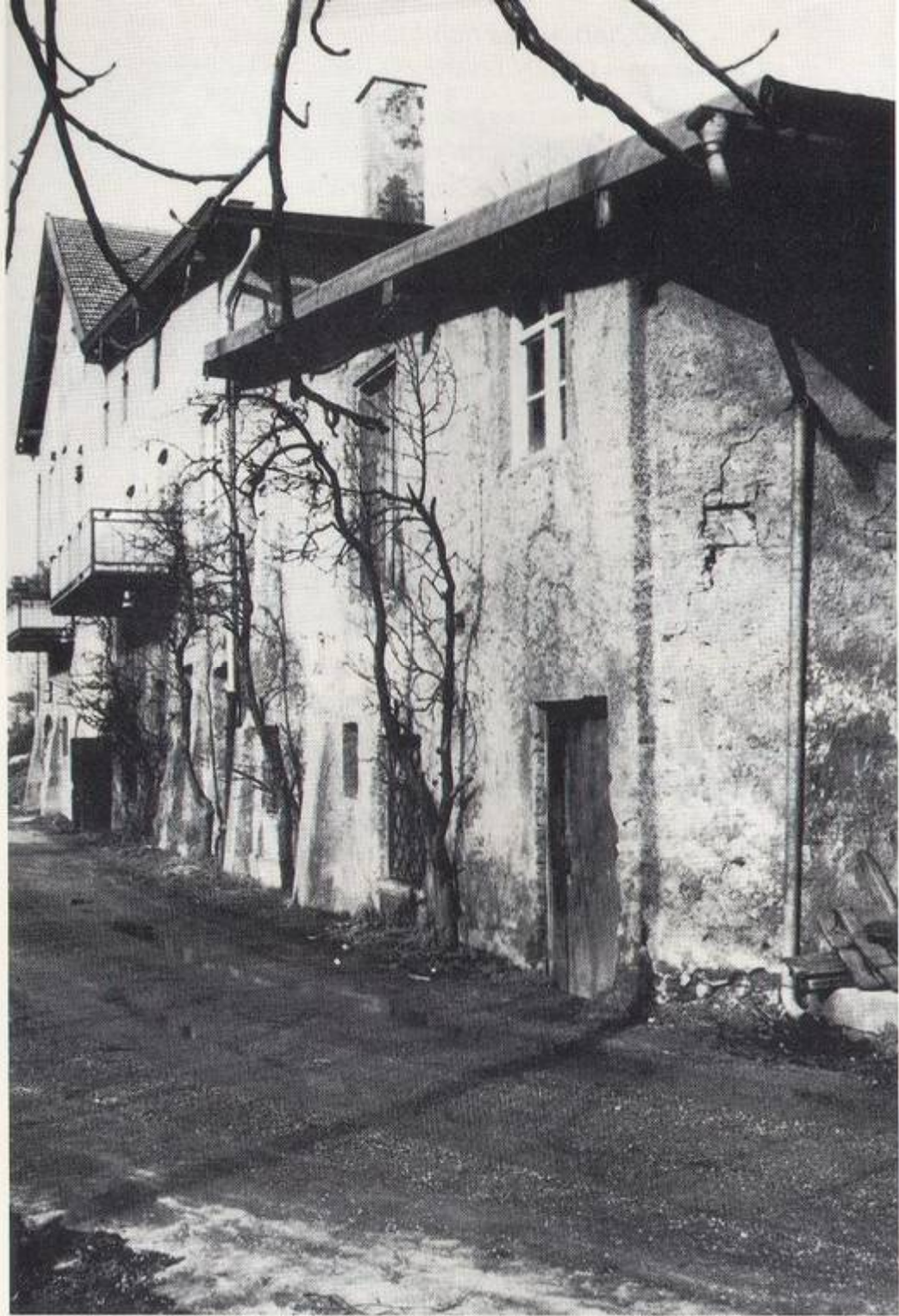
Die alte Unterkunft in der ehemaligen »Brunner-Brauerei«
