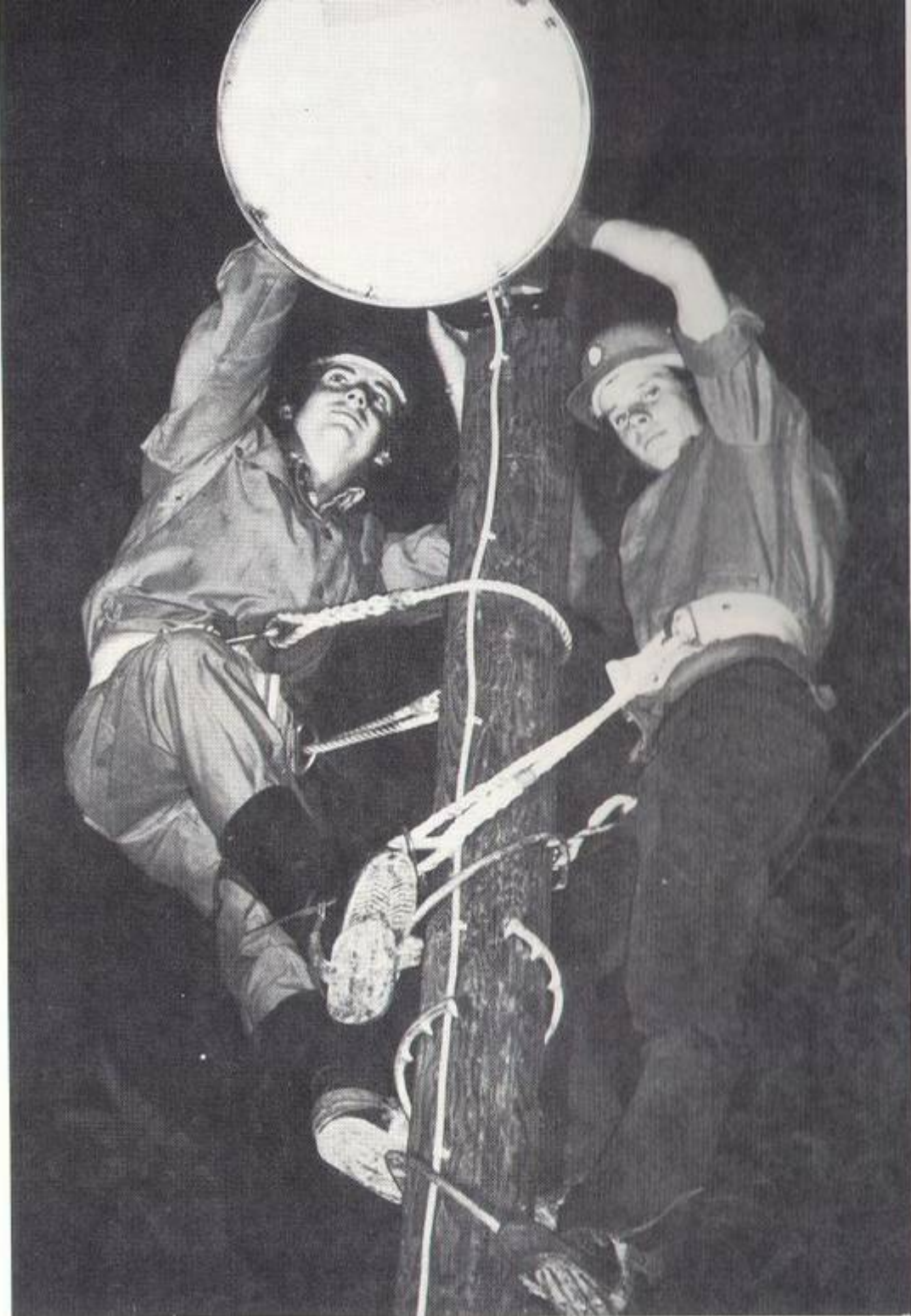
Ausbildung der F-Gruppe im Freileitungsbau
